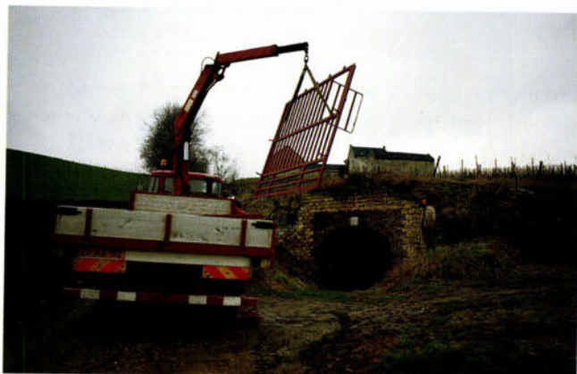
FIGUUR 3 Plaatsing door de Studiegroep Onderaardse Kalksteengroeven (SOK) van een hek bij in de ingang van de Apostelgroeve op 13 maart 1981 (foto: Ton Breuls).
